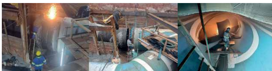
Figura 19 - Dia da paralisação – Serviços de interligação à montante – Interligação da adutora remanejada em 1982
