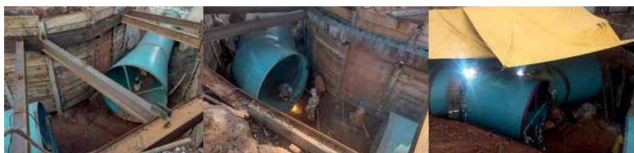
Figura 14 - Etapas de montagem à jusante
