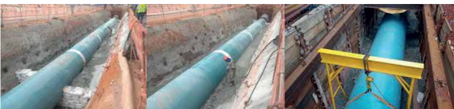
Figura 12 - Lançamento e montagem do trecho linear
