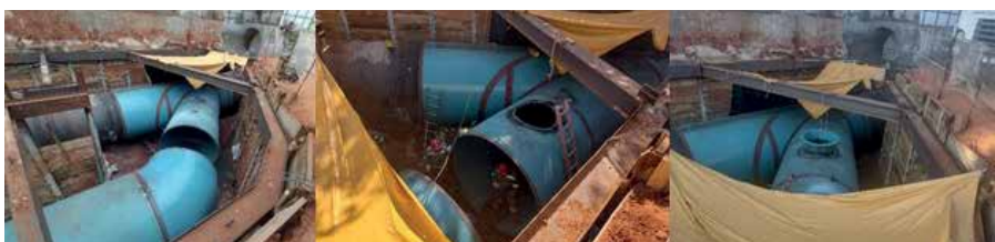
Figura 13 - Etapas de montagem à montante
