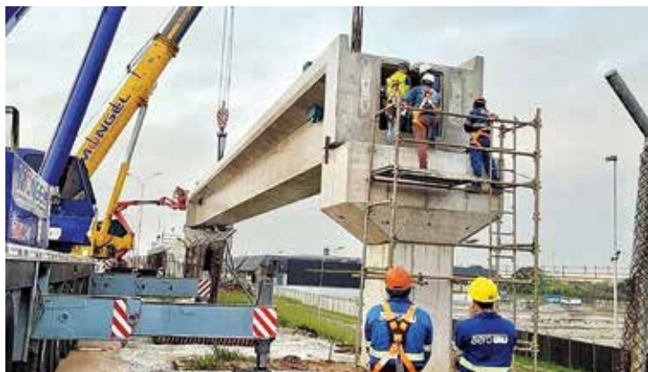
Çamento de viga, etapa já concluída
