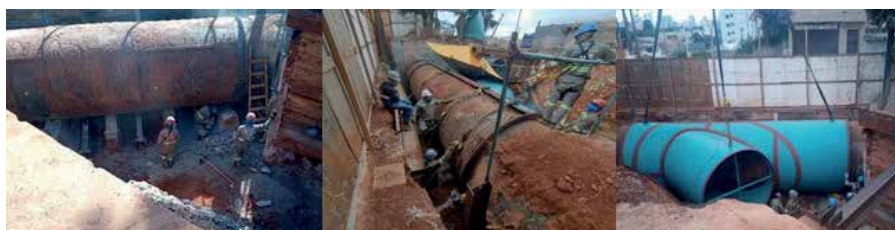
Figura 18 - Etapas de montagem da derivação à jusante
