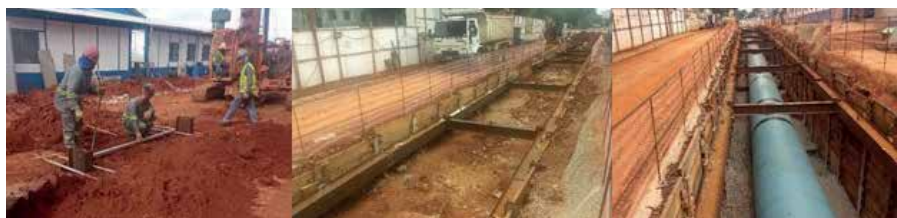
Figura 10 - Pré-furos, vala em perfil pranchado e assentamento da adutora
