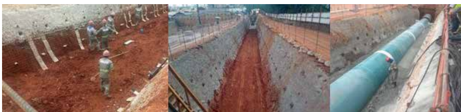
Figura 11 - Vala em solo grampeado, assentamento da adutora e aterro hidráulico
