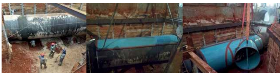
Figura 17 - Etapas de montagem da derivação à montante
