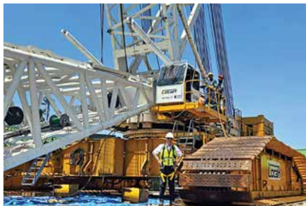
Super guindaste utilizado no içamento das vigas
