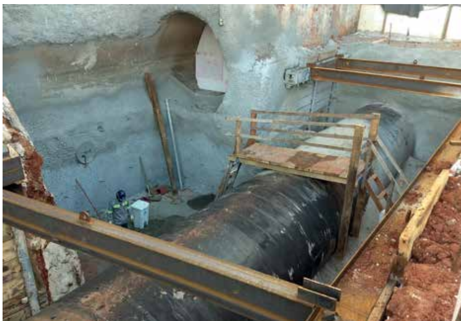
Figura 2 - Adutora remanejada na década de 1980 e aqueduto de concreto desativado na época
